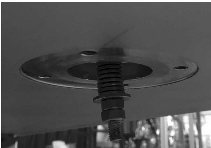
Abbildung 18: Untere Zugstrebe mit Tellerfederpaket
